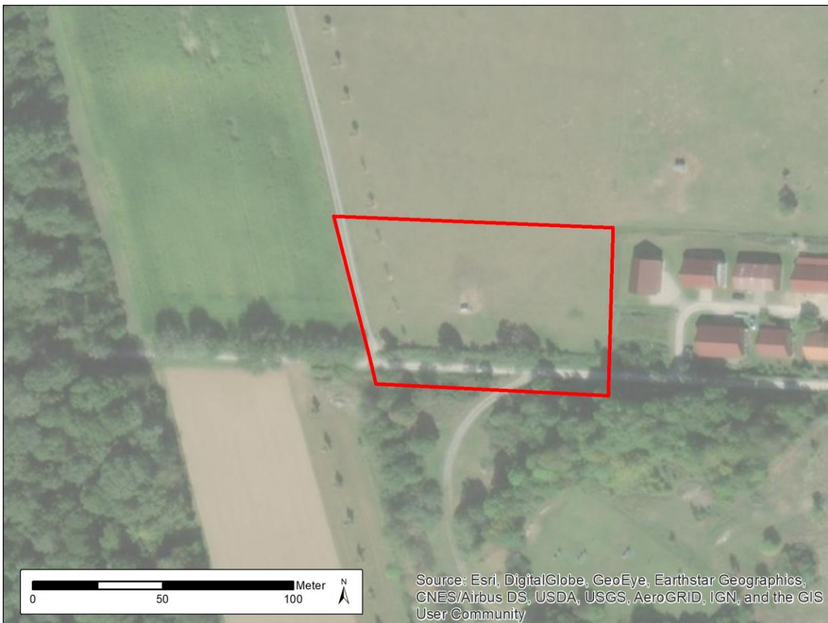
Abb. 1: Luftbild mit Geltungsbereich des Bebauungsplans zur Erweiterung der Schuppenanlage am Rößweg (rot umrandet).
