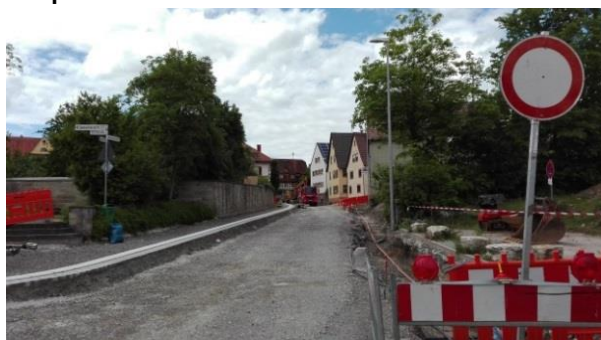
Abbildung 16: Sanierung Ortsdurchfahrt - Bismarckstraße
