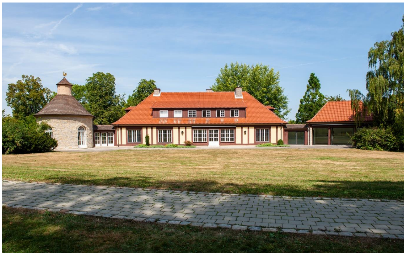
Abbildung 14: Villa Schwalbenhof, saniert außen
