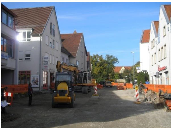
Abbildung 15: Sanierung Ortsdurchfahrt - Hauptstraße
