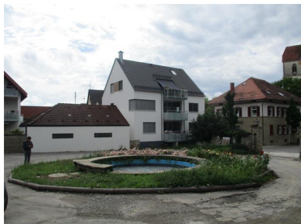
Abbildung 27: Unsaniertes Brunnen, Zustand Juli 2018
