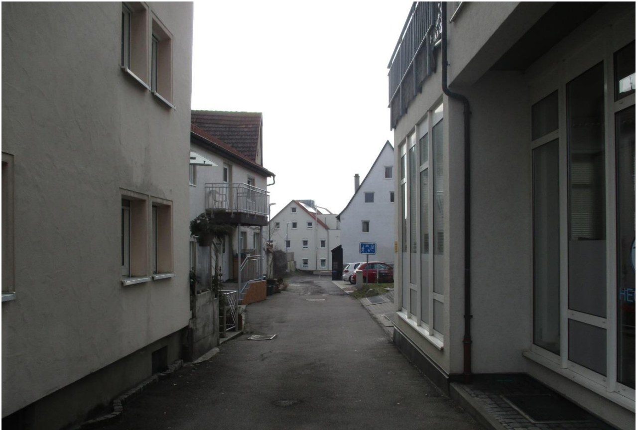
Abbildung 88: Sanierungsbedürftige "Enge Gasse"
