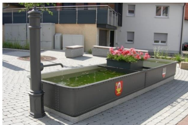
Abbildung 21: Sanierung des Brunnens
