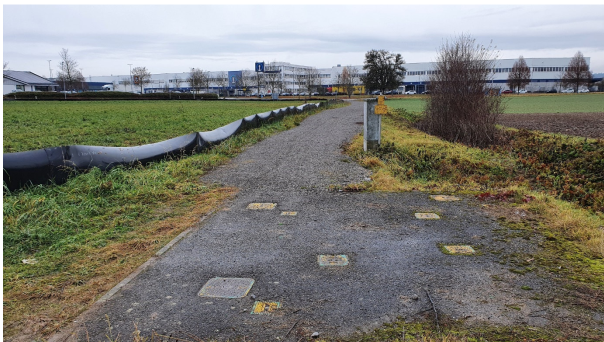
Abbildung 5: Änderungsbereich 3; Am Nordrand der abgesperrten Fläche; Blickrichtung West (G. Samsel, 2021)
