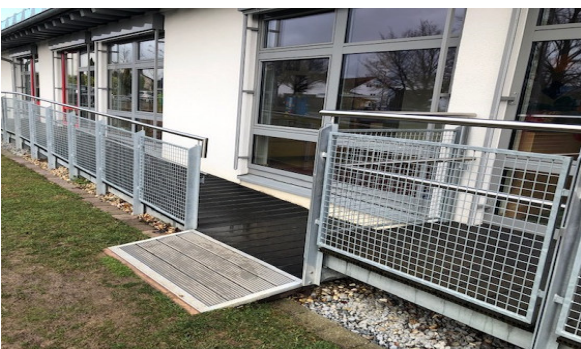
Bild 22: Rampe Kindergarten Schickhardtstraße; Quelle Schickhardtstraße
